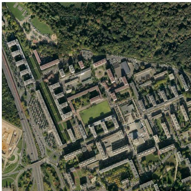
Avenue du Général de Gaulle, Meudon, France
